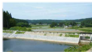
防災重点農業用ため池の改修
