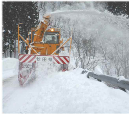
道路除雪作業
