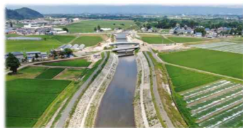
洪水被害が発生した河川の改良復旧
