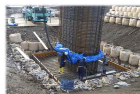
橋梁の耐震補強工事
