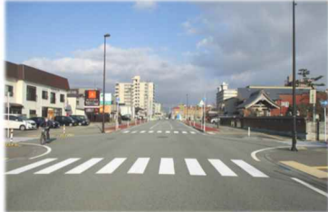
街路整備・無電柱化による道路環境の改善
